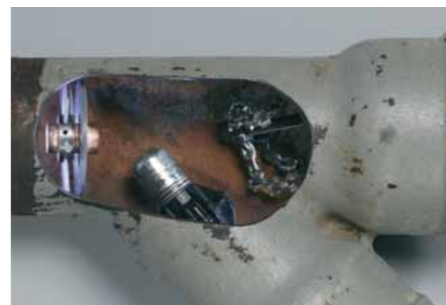
Massaruisku, kamera ja puhdistustyökalu vanhassa putkessa.
