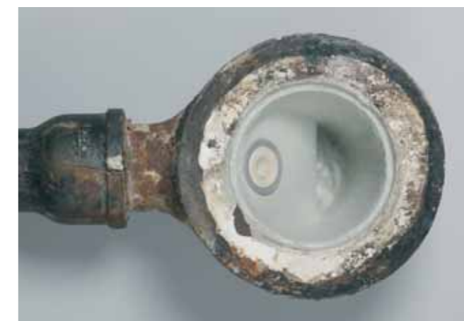
Vanha lattiakaivo on saanut uuden TUBUSpinnoitteen.
