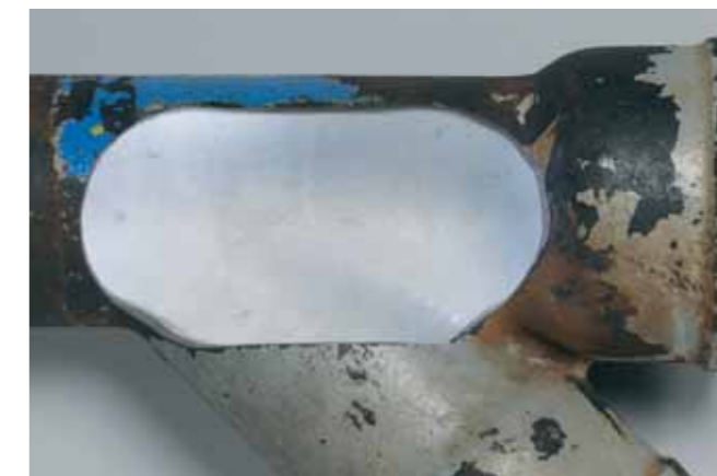
Uusi TUBUSpinnoite vanhan putken sisällä.
